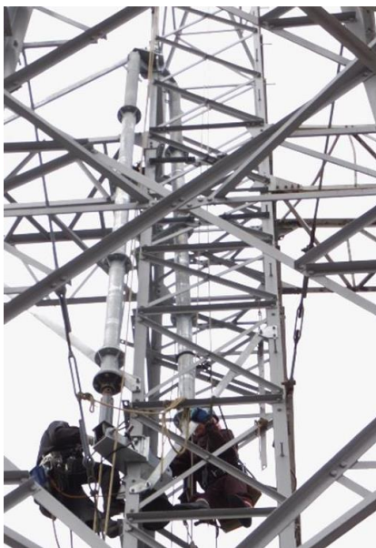
腐食した支柱材の取り替え
