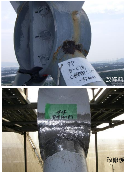
添え板溶接設置による補強
