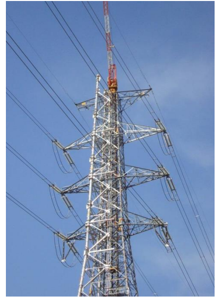
2脚1/2面包み込み鉄塔建替工法
