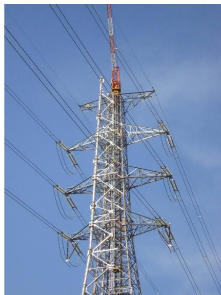
275kV東信新北信線建替工事(中部電力様) (耐張鉄塔→分岐鉄塔)
